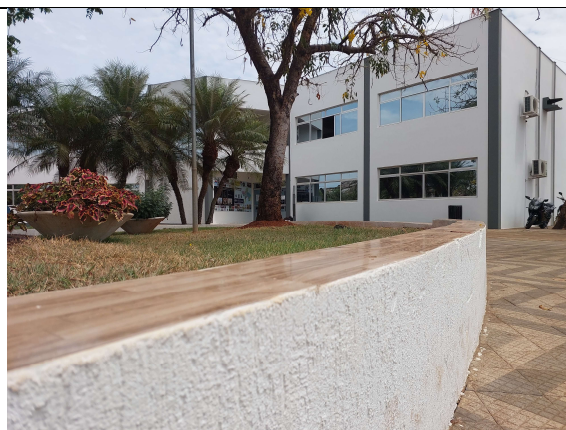
Foto 12: Em detalhe, verifica-se substituição de arremates em granito por cerâmica. Renan Costa, 14 out. 2025.
