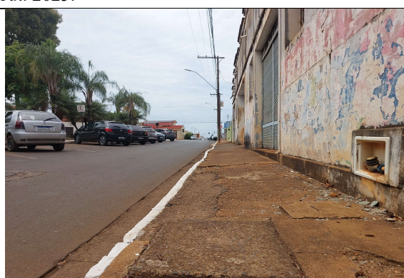
Foto 12: Em detalhe, verifica-se substituição de arremates em granito por cerâmica. Renan Costa, 14 out. 2025.
