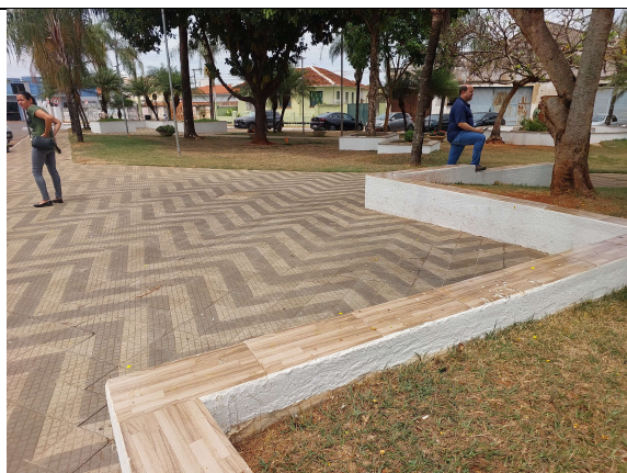
Foto 9: Trecho de canteiro, conformando bancos, com substituição de arremate em granito por cerâmica. Renan Costa, 14 out. 2025.
